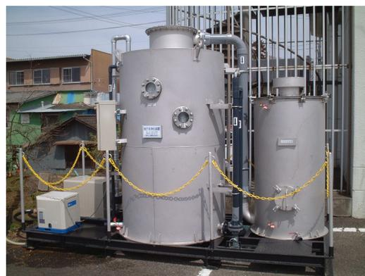
汚染した地下水を汲み上げ、曝気塔内へ空気を導入し、水中のVOCを空气中に追い出します。曝気塔のタンクは地下水に含まれるVOCを追い出すのに最適な構造に設計され、効率の良い除去が行われます。空气中に追い出されたVOCを活性炭塔の活性炭で吸着し、空気をきれいにします。また、曝気により除去しきれなかった微量のVOC除去のために、処理水を活性炭吸着する場合があります。
